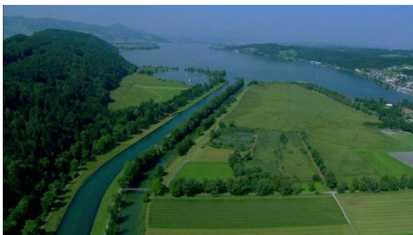
Linthkanal mit Einlauf in den Zürichsee
